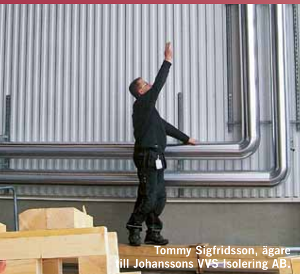
Alutec beklädda rörskålar mot värmebatteri.
